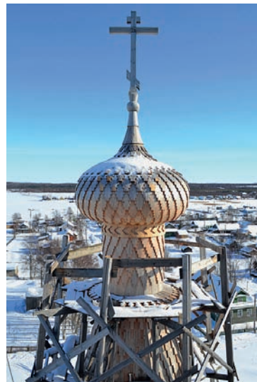
ТРОИЦКАЯ церковь. Реставрация придельного шатра и главы
